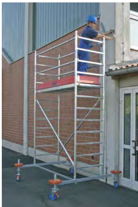
Gerüstfeldlänge: 2,00 m – Gerüstfeldbreite: 0,75 m
