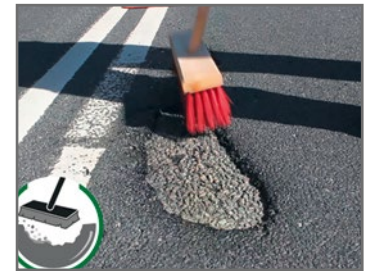
Schnelle und einfache Reparatur
