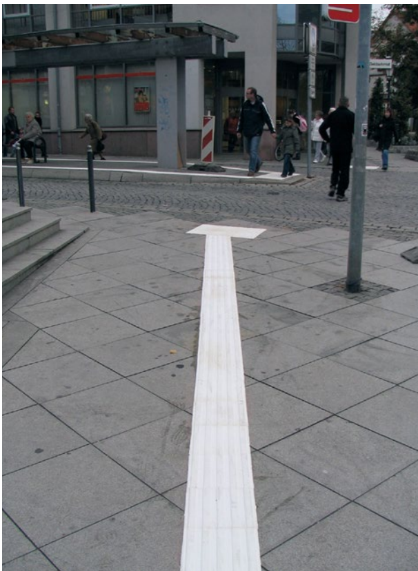
Taktile Markierungen helfen Sehbehinderten, sich besser zurechtzufinden
